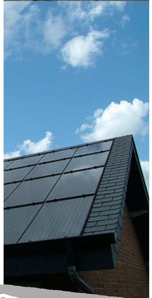
Die Solarziegel **SL3M150** und **SL5M142** vereinen die Eigenschaften eines Hochleistungsmoduls mit den Vorteile eines einzigartigen 6mm starken Laminates.
